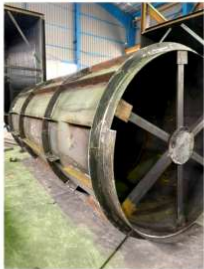
پروژه ساخت داکت شرکت فولاد خیام نیشابور
